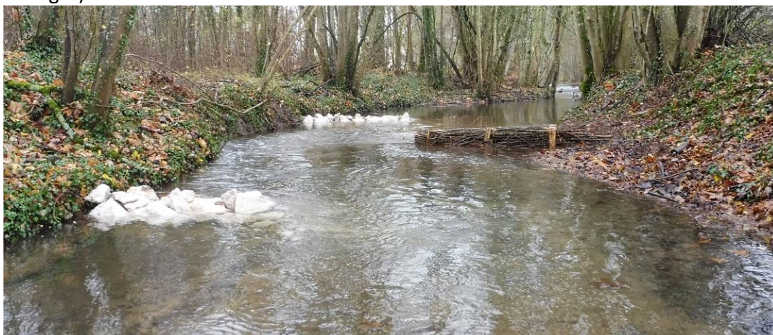
Réalisation d'épis sur la Cent Fonts Commune de Saulon-la-Rue - Décembre 2018
