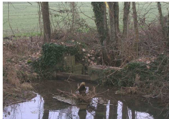
L'ouvrage de répartition à aménager
