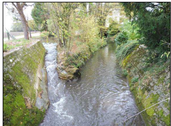
Après travaux Retablisement de la continuité biologique
